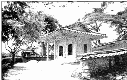
▲ 증건중인 영락정 전경(문경)
